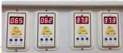
En situation normale, les contrôleurs principaux fonctionnent et règlent la température et l'humidité.
