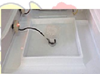
تا زمانی که رطوبت پایین تر از میزان تنظیم شده باشد چراغ پکیج رطوبت روشن می باشد و رطوبت ساز کار می کند.
